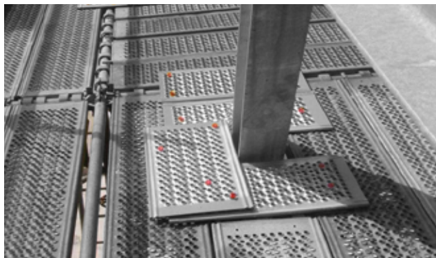
Voorbeeld van het gebruik van de overlapvloer.
