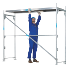
Monteer diagonaal en vloer
